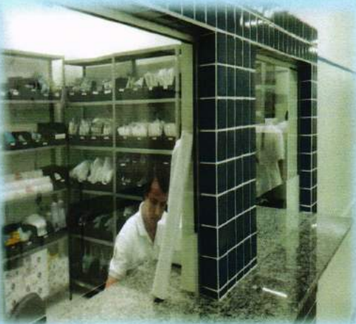
COLOCAÇÃO DE VIDRO: FARMÁCIA
