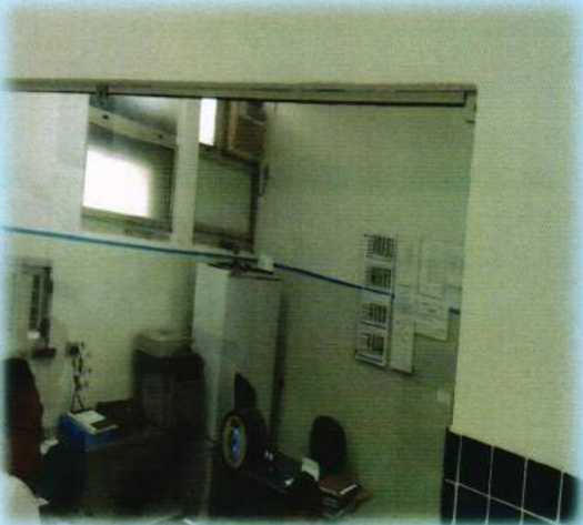
COLOCAÇÃO DE VIDRO: RECEPÇÃO
