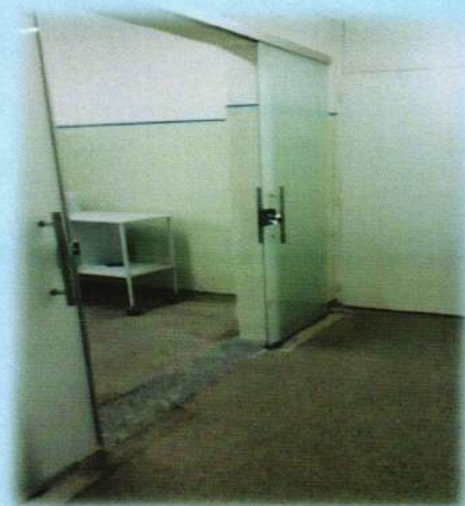
REFORMA COMPLETA DA SALA AMARELA E COLOCAÇÃO DE PORTA DE VDRO
