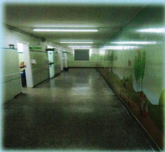
PEDIATRIA: REFORMA DE SALAS E COREDOR
